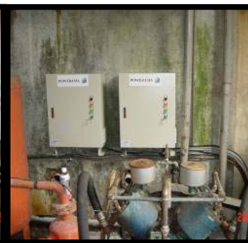
圖 3 SES-VR 外掛式智能變頻節能系統安裝圖
