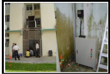
圖 21 AC 變頻安裝圖(銀行空調設備)
