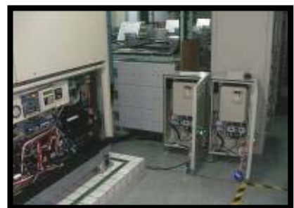
圖 13 SES-VR 電信機房變頻節能系統安裝圖
