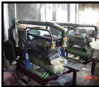
圖 2 食品工廠冷凍庫壓縮機圖
